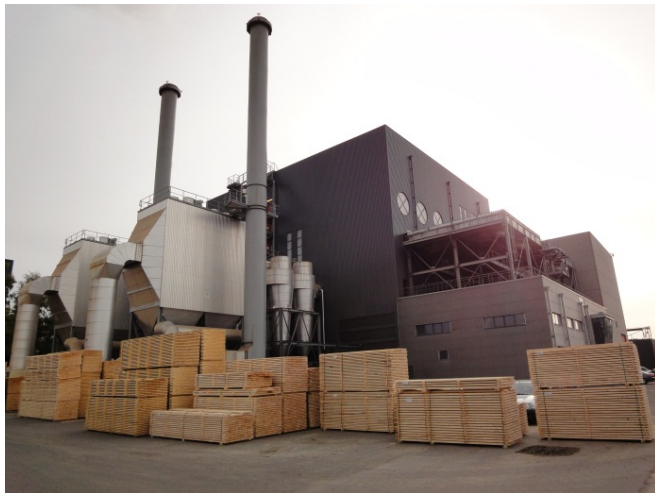
Bild 1: Das Biomasse-Heizkraftwerk der Industrie du Bois Vielsam & Cie. s.a. (IBV) in Belgien.
