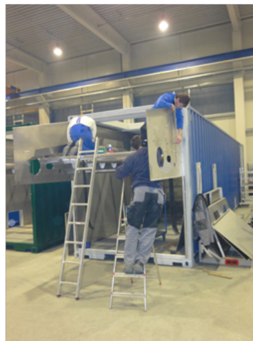
Bild 2: Die komplette Vorfertigung erfolgt im Werk.
