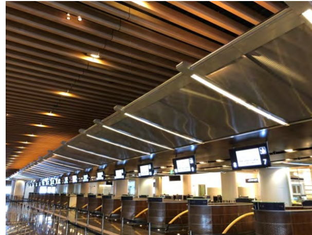
Bild 2: Die Immigration-Counter im mittleren Gebäuderiegel werden durch auskragende Dächer aus Edelstahlgewebe von GKD zum optischen Highlight.
