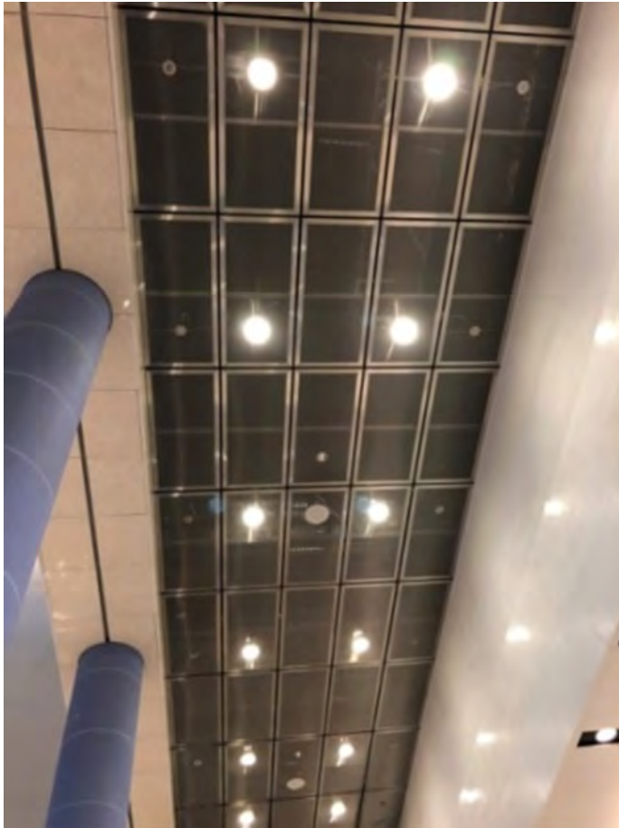
Bild 1: Jeweils 200 Quadratmeter der Rasterdecke aus Metallgewebe von GKD markieren die Übergänge zum nördlichen und südlichen Pier.
