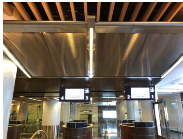
Bild 3: Auskragende Dächer aus Edelstahlgewebe von GKD überdachen die Schalter und schaffen so ein repräsentatives Willkommensareal.
