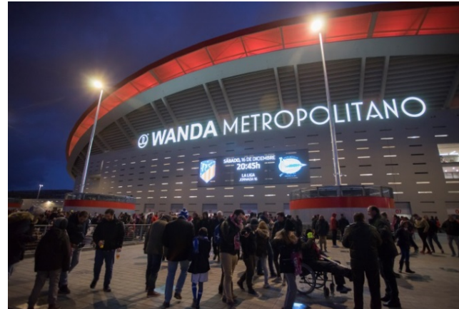
Bild 5: Das spektakulär geschwungene Dach mit integrierten LED-Bändern, die helle, horizontal perforierte Fassade und das großformatige MEDIAMESH®-Display bilden ein homogenes Miteinander.
