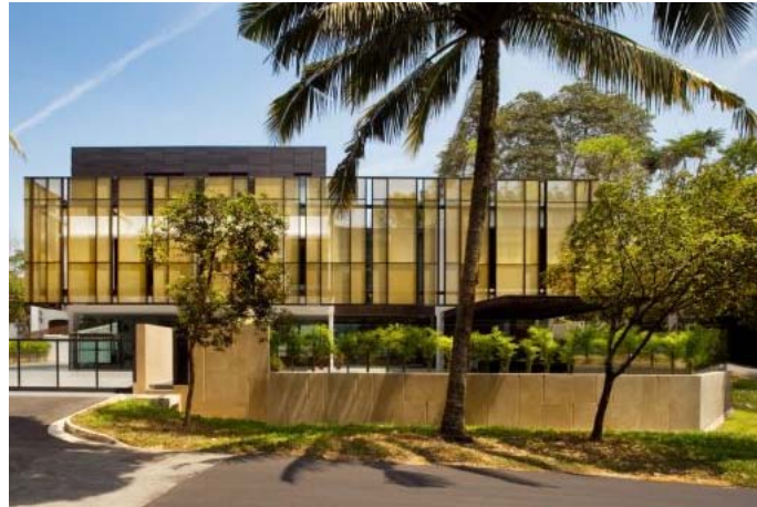
Bild 6: PC-Gewebe von GKD verbindet edle Optik mit Pflegeleichtigkeit, Korrosions-, Witterungs- und UV-Beständigkeit, hier als farbig eloxierte Fassadenverkleidung vom Typ PC-Alu 6010.
