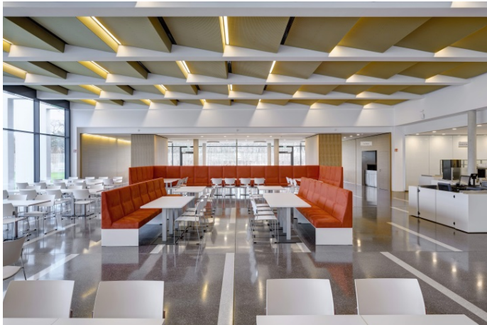
Bild 5: Vorgekröpfte, in beiden Richtungen starre, PC-Gewebe sind dank Rahmenkonstruktionen einfach als homogene Verkleidung an Decken zu montieren, wie hier der Typ PC-ALU 6010 in der Kantine der Europäischen Organisation für Betrieb und Auswertung meteorologischer Satelliten (EUMETSAT).
