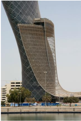
Bild 9: Für das luftig anmutende Gewebeband am Capital Gate Tower wurden alle Paneele unterschiedlich stark verzogen.
