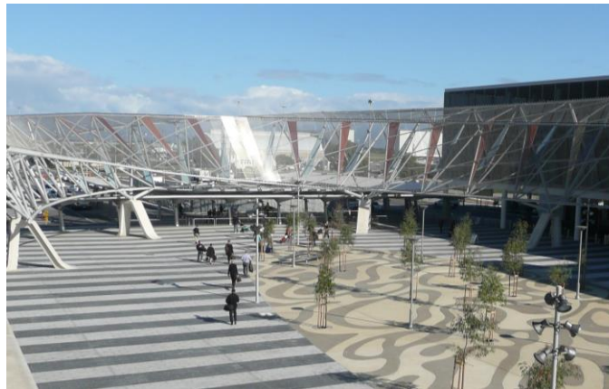
Bild 8: Für die in sich verdrehte, halbkreisförmige Überdachung am Adelaide Airport, Australien, wurde jedes der 270 Paneele individuell gezeichnet und die notwendige Spannung berechnet.
