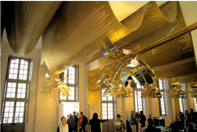
Bild 7: Für die skulpturale Deckengestaltung im Pavillon Dufour, dem neuen Haupteingang von Schloss Versailles, entwickelte GKD eine neuartige Gewebetechnologie.
